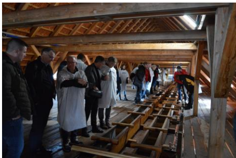
Foto: DSC 0170.JPG Motiv: Besichtigung der Ostwand
